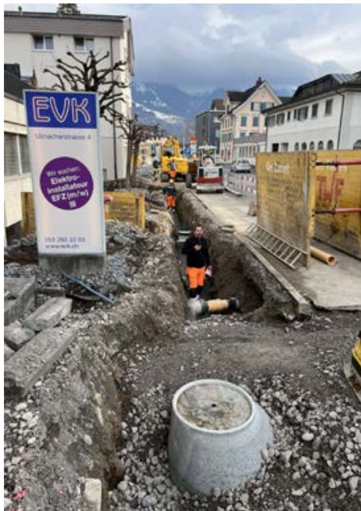
Graben für Entwässerung an der Uznacherstrasse
