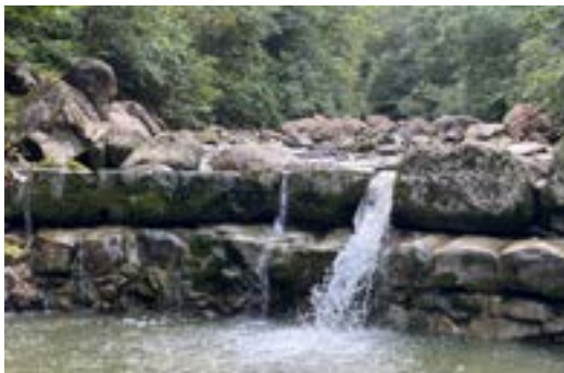
Fischabstieg bei Wasserfassung
