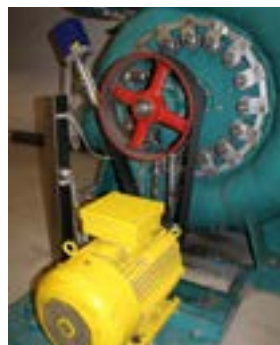
Turbinenanlage KKW Bruggmühle
