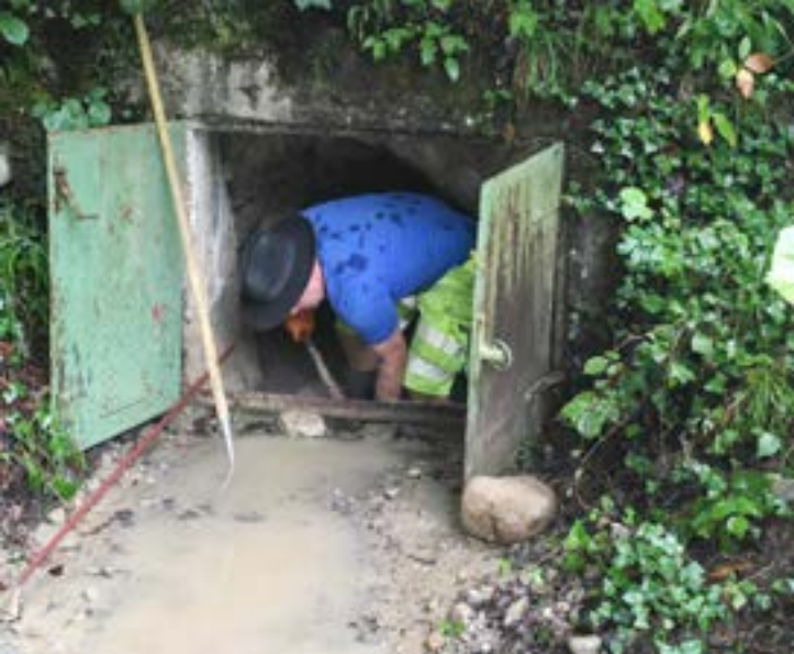
Reinigung Zulaufkanal Kleinwasserkraftwerk Wilen (links), Wasserfassung Kleinwasserkraftwerk Bruggmühle
